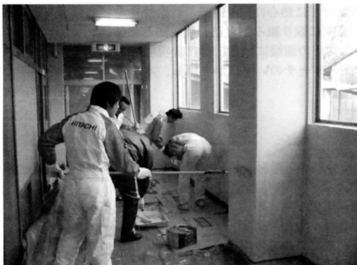
有志による校舎内壁塗装作業の様子
