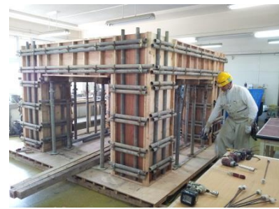
型枠施工完成
