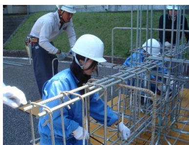
基礎梁の配筋作業の様子。図面を確認しながら主筋やあばら筋を配筋していく。
