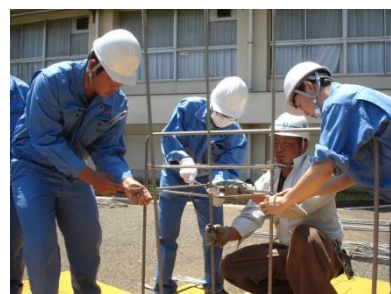
柱の帯筋（フープ筋）を所定の間隔になるように主筋と結束する。
