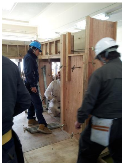
梁型枠建込み
