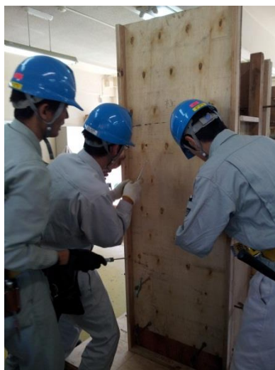
柱型枠建込み
