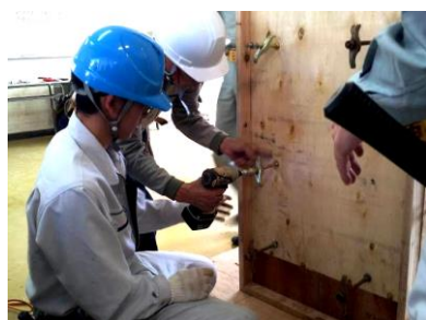
柱型枠建込み
