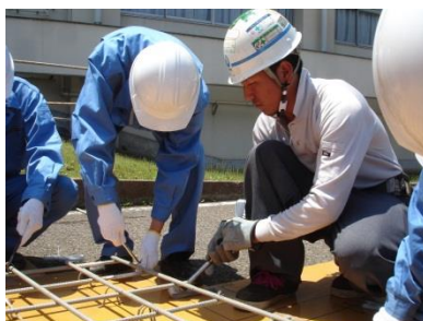
フーチング（基礎）の配筋作業の様子。講師の企業技術者は県内工業高校建設科の卒業生。
