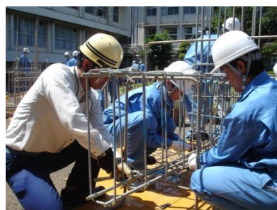
基礎梁の配筋作業の様子。あばら筋（スターラップ）と主筋を結束する。角部はたすき掛けとする。
