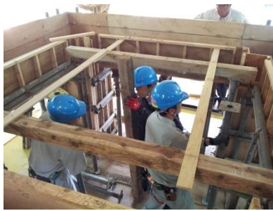
スラブ型枠建込み準備
