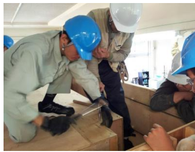
スラブ型枠建込み
