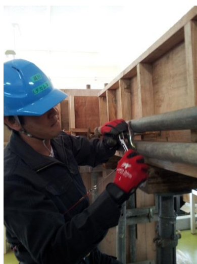
支保工の取付け
