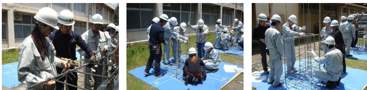
図4 鉄筋組立実習の様子（平成26年度）
