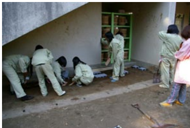
図14 棚の設置場所の整地作業
