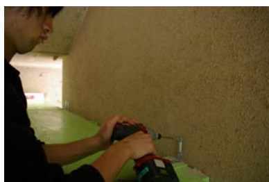
図8 棚をL字金具で接合する
