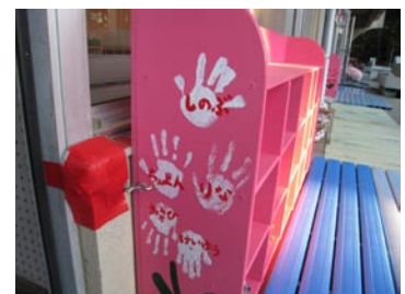
図22 壁に転倒防止の金具を設置する
