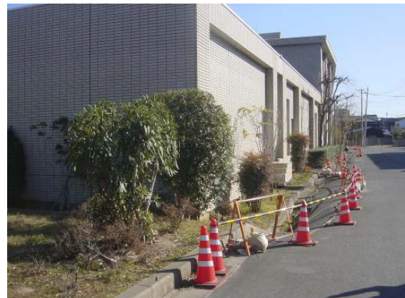
図 2 旧佐原港地域の液状化現象 入船橋ポンプ場脇の路面の陥没
