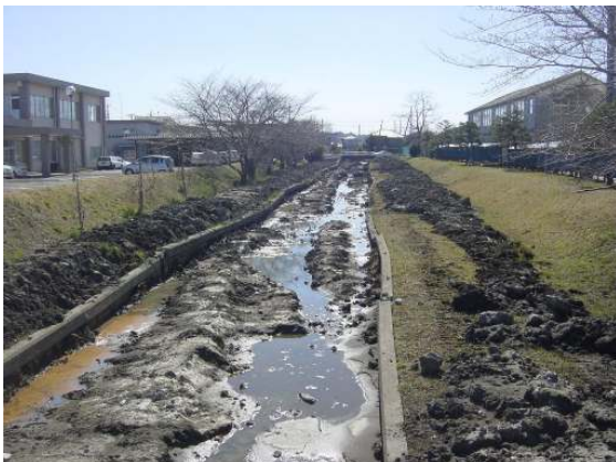
図 1 利根川右岸地域の液状化現象 香取市十間川の川底からの噴砂
