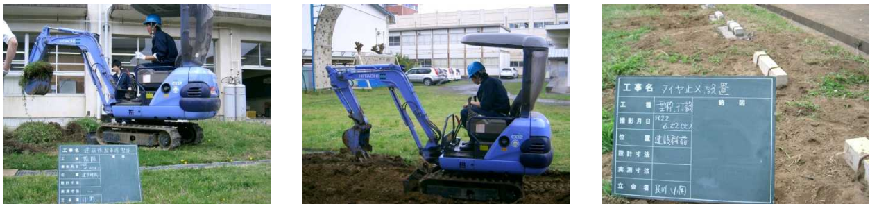
図1 駐車場整備の様子
