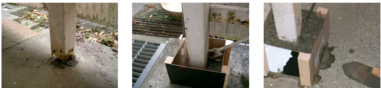
図2 柱修理の様子
