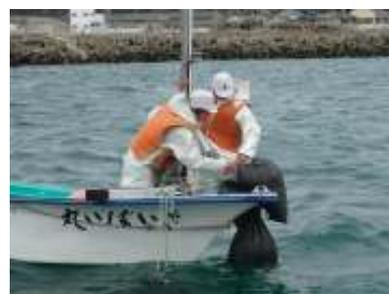
実習船から複数の土のうを設置地点に投入するのは大変危険を伴う作業である。触先に均等に吊り下げ、止めのロープをナイフで切断すると240 kgを超える土のうが落下する。土のうに結束したロープが暴れるように追従していくため船上で最大限の注意が必要な作業である。
