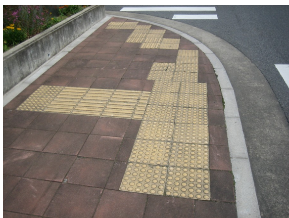
図4 点字ブロック
