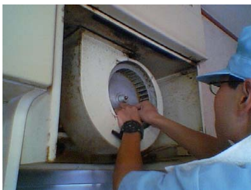
図 22 レンジフードの清掃
