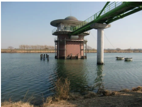
【江戸川からの取水塔を望む】
