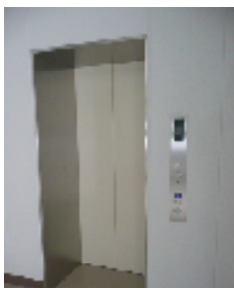
管理棟に設置
