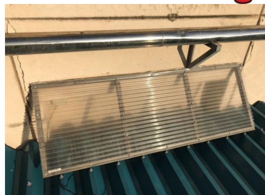
食堂へ続く通路の屋根
